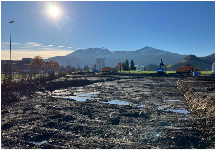
Der PFAS-belastete Boden und Untergrund wird schichtweise (Schichtdicke 30–40 cm) abgetragen, bis das Sanierungsziel erreicht ist.
