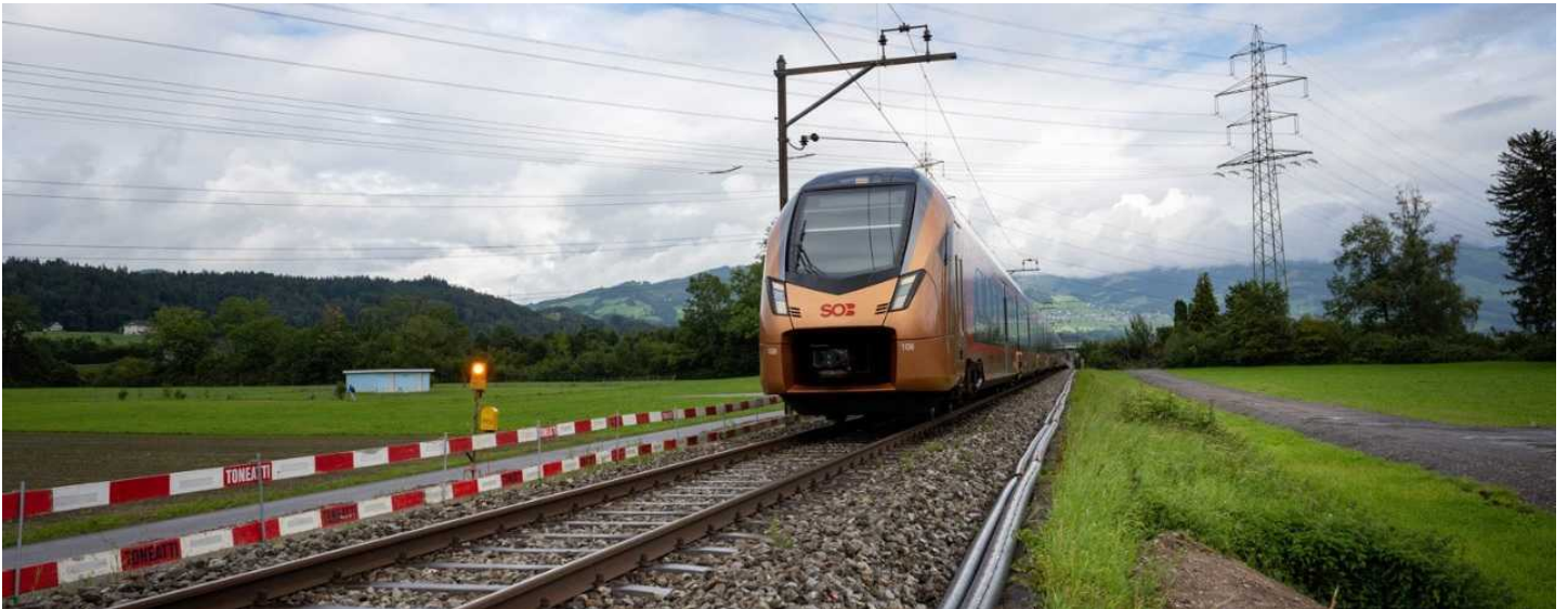
Doppelspurausbau zwischen Uznach und Schmerikon, Foto: SOB
